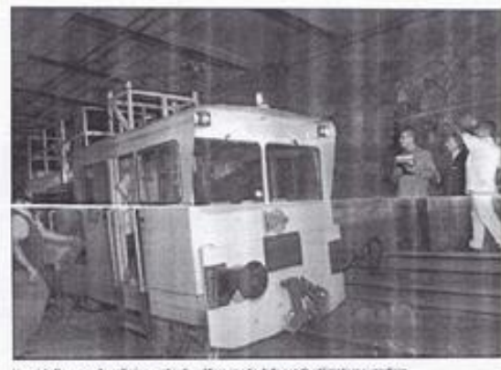
lavoro nella galleria per chiudere il foro aperto dalla sonda utilizzata in superficie
