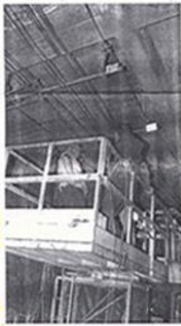
Operai al lavoro per ripulire la linea di alimentazione del metrò. A destra, il presidente del Cetral Mario Di Carlo accorre sul posto
