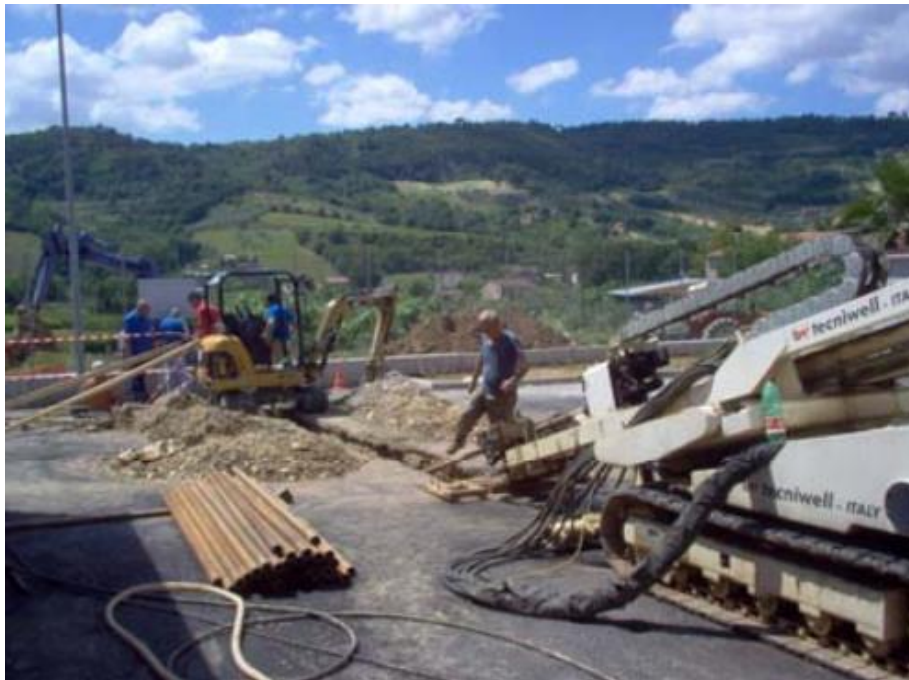
FIG. III-06 CANTIERI VARI IN CENTRO ITALIA ANNI 2000 - 2004
