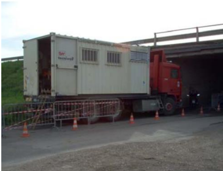
FIG. III-04 CANTIERE FASTWEB A MACCARESE (ROMA) ANNO 2004
