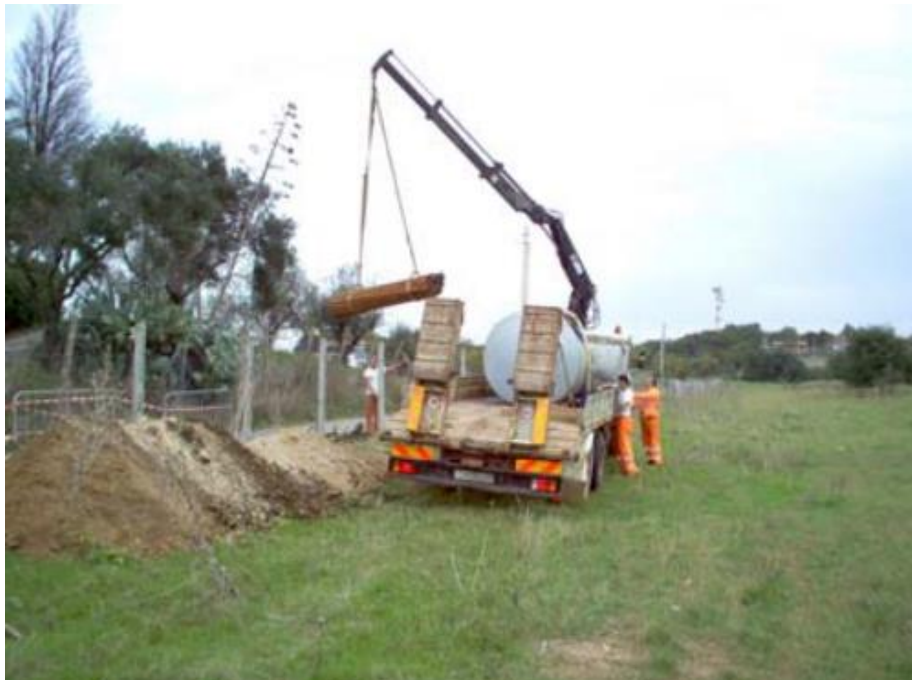
FIG. III-03 CANTIERE FASTWEB A MACCARESE (ROMA) ANNO 2004
