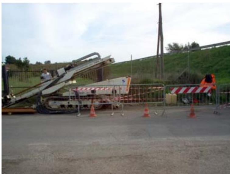
Iury Gututui ai comandi della sonda TECNIWELL TWH12 della NEO.TECH S.r.l. Maccarese, 2004
