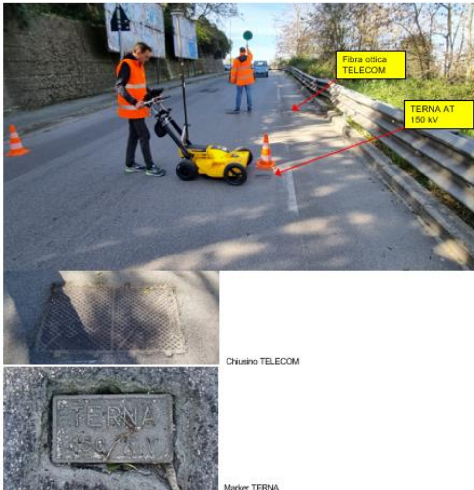
FIG. 04 ESTRATTO DA RELAZIONE TECNICA Cliente: TERNA – General Contractor: SCANGEA CONTRACTING – Georadar and Design Sub-Contractor: SCANGEA ENGINEERING Progetto: RILIEVO GEORADAR PER MAPPATURA DEI SOTTOSERVIZI E PROGETTO DI MASSIMA DELLA LINEA INTERRATA TERNA DA 150 kV “C.P. MATERA NORD-C.P. MATERA SUD” MATERA, 2022-2023
