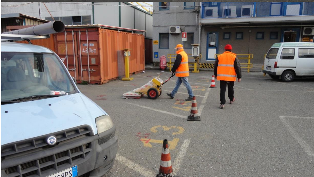
RILIEVO GEORADAR ZONA UFFICI PROSSIMA A STIVA 2A
