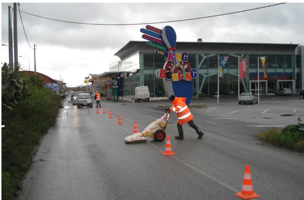
PipeHawk al lavoro per TERNA - NEXANS a Milazzo (MS) – Gennaio, Febbraio 2010
