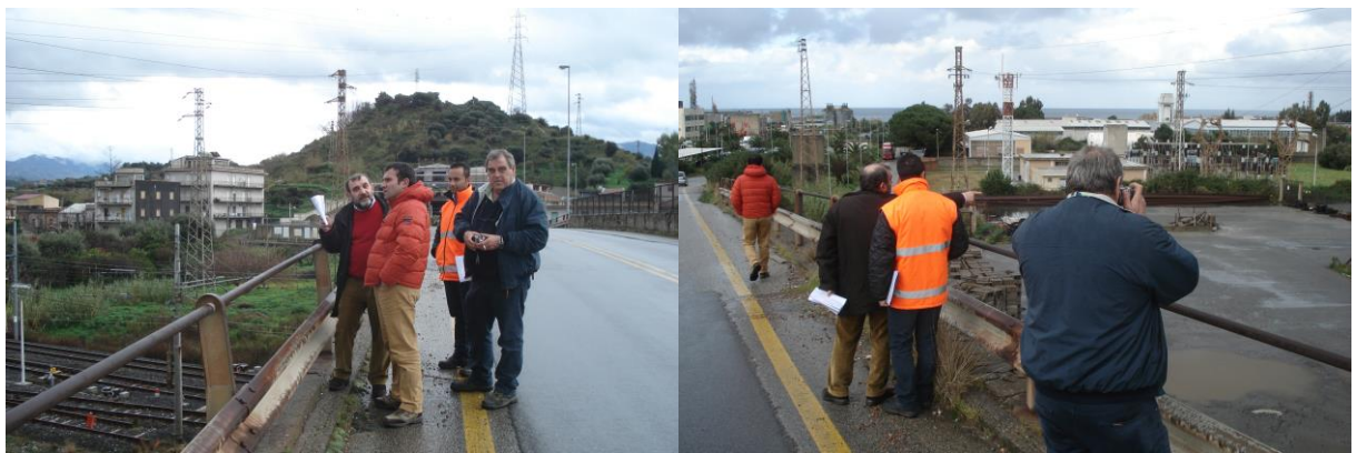
Sopralluogo del Project Manager TERNA del 21 Gennaio 2010.
