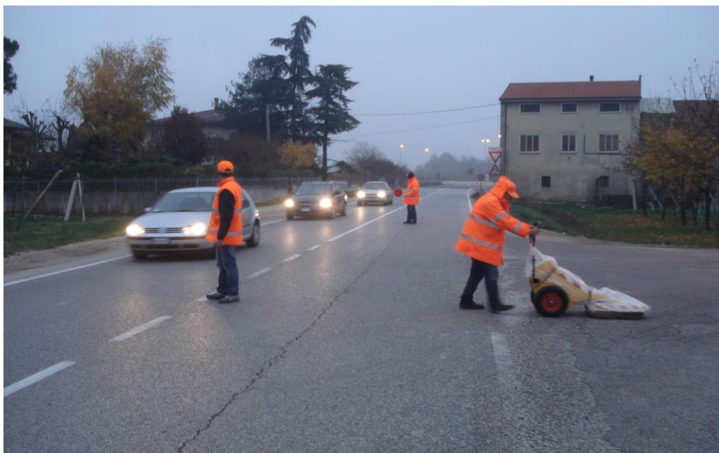
PipeHawk al lavoro per NEXANS a MONTEBELLO VICENTINO (VI) - Novembre 2009
