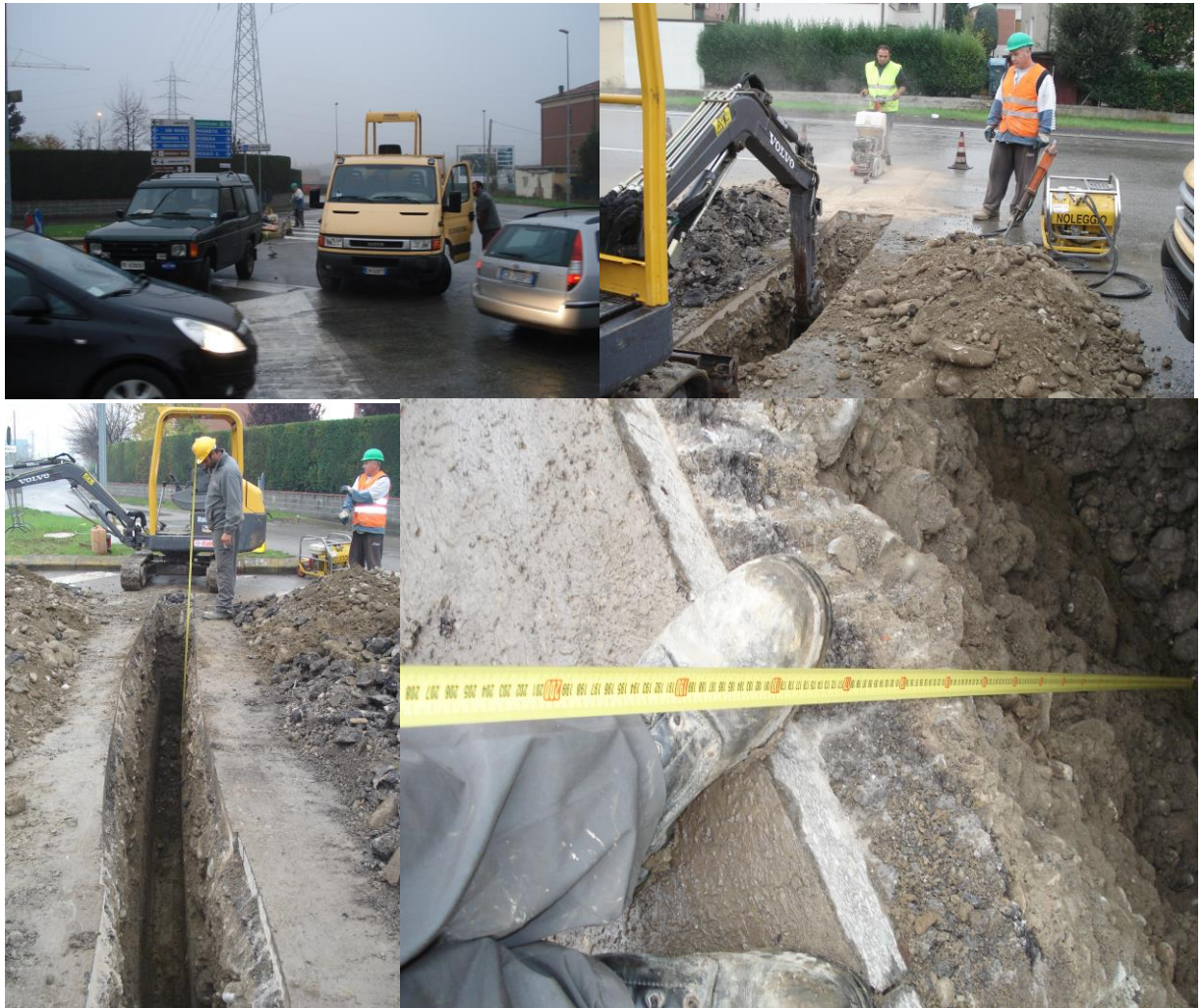
Figura 3 SCAVI SAGGIO – Saggio B (0,4 x 8,0 m)
