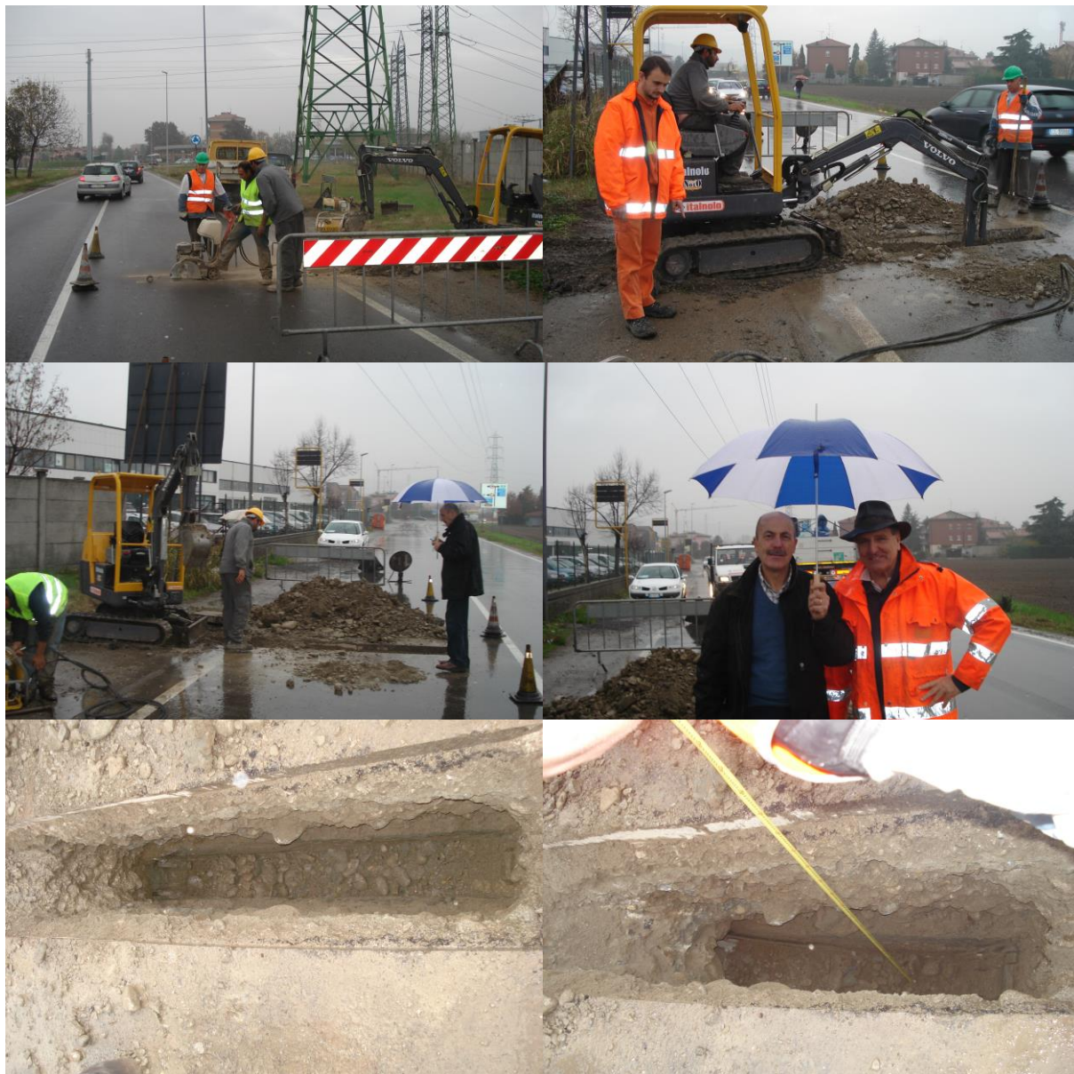
Figura 5 SCAVI SAGGIO – Saggio A (0,4 x 4,0 m)
