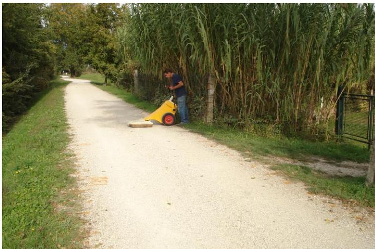
L'area interessata dal tracciato del progetto di massima di TERNA è stata esplorata con il georadar il giorno 17 Ottobre 2007. Sono stati rilevati N. 24 moduli di 3x3 metri (dal 107 al 130), per un totale di 216 mq. I moduli sono allineati in una stringa parallela all'asse della strada vicinale, che non è asfaltata ed è larga circa 3 metri. La lunghezza della stringa è pari a 72 m.
