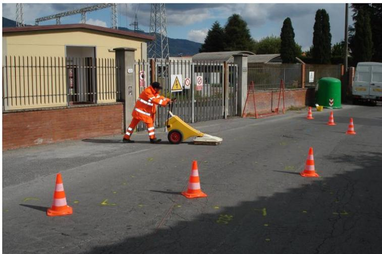
La lavorazione prevista per questa tratta è la perforazione orizzontale guidata (HDD). Il lancio avverrà in golena, nel punto di stazione topografica N e l'arrivo sarà all'interno dell'area della C.P. San Pietro a Vico. Il rilievo georadar è stato svolto sulla strada asfaltata antistante all'ingresso della C.P. perché in quest'area (in cui la perforazione risale) l'elettrodotto potrebbe interferire con i servizi esistenti.
