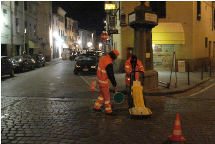
L'area interessata dal tracciato del progetto di massima di TERNA è stata esplorata con il georadar la notte del 3 Novembre 2007. Sono stati rilevati N. 6 moduli 3x3 metri (dal 1076 al 1081), per un totale di 54 mq. I moduli sono ordinati in due insiemi quadrati aventi ciascuno il lato pari a 6 metri. Ciò ha permesso di coprire l'area in cui il tracciato del cavo gira intorno all'Indicatore.
