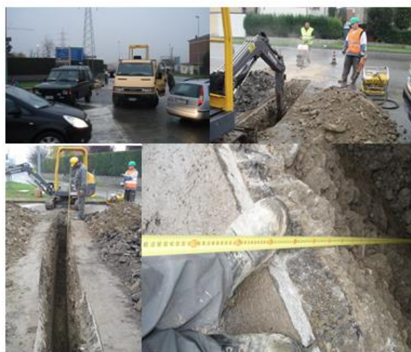
Figura 3 SCAVI SAGGIO – Saggio B (0.4 x 8.0 m) Il 12 novembre 2008 sono stati fatti N.2 scavi di saggio: Saggio A e Saggio B (vedi planimetrie TIMESLICES) Nell'immagine: Saggio B, inizio operazioni, scavo, foto scavo ultimato.
