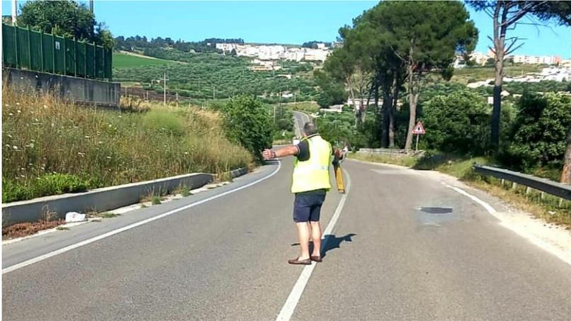
L'Ing. L.C.Speranza indica la direzione dei cavi elettrici rilevati dal Radiodetection
